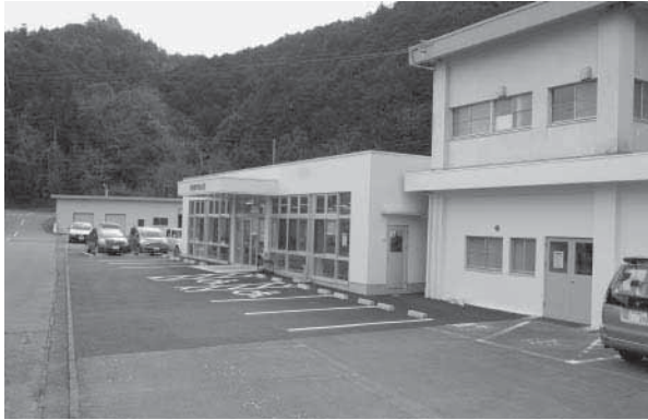
カメラ方向② 庁舎分室と駐車場
