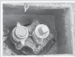
▲消火栓と書かれたフタを開けたところ。凹部分にホースの口(↑)を取り付け、凸部分には開閉棒を取り付けます。ホースのもう片方には筒先を取り付けます。
