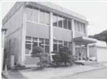
分館A棟1階 (旧大紀森林組合大宮事業所) 環境水道課 (環境係、簡易水道係)
