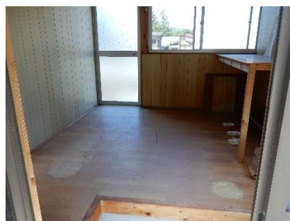
倉庫内部①
