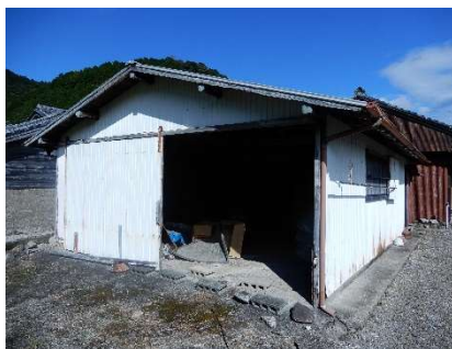
附属屋外観 (倉庫)
