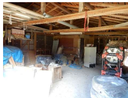
附属屋内部 (倉庫)
