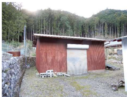
倉庫③外観
