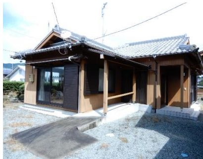
建物 2 スロープ
