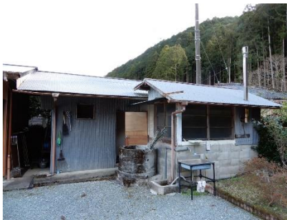
倉庫①外観
