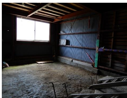
倉庫①内部
